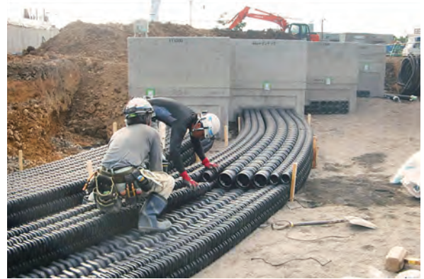
写真5 配管ノーマル部分
