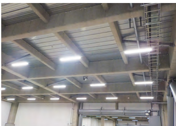
写真6 倉庫内照明設備設置状況
