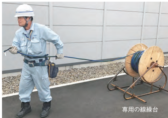
写真2 ドラム巻き電線の延線作業
