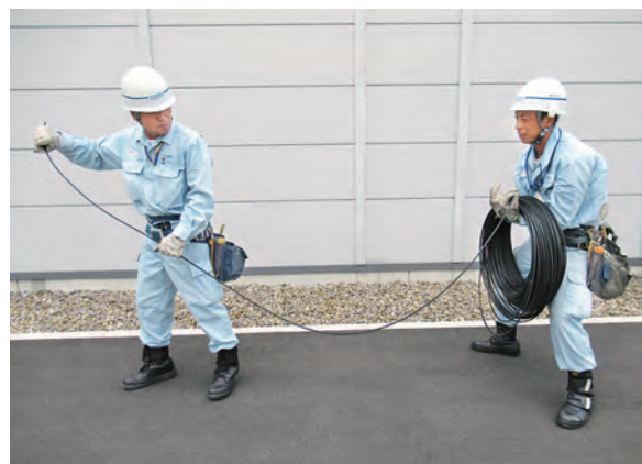
写真3 束巻き電線の延線作業
