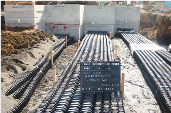
写真3 配管施工状況
