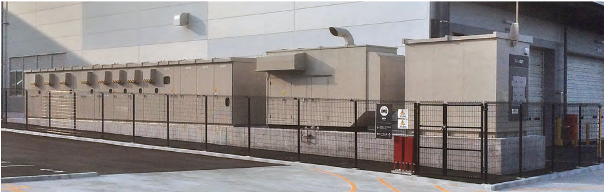
写真1 No.1キュービクルおよび非常用発電機・オイルタンク
