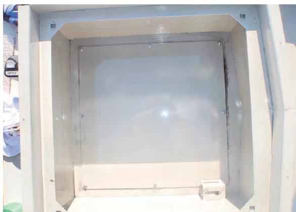
写真15 天井換気扇の閉塞
