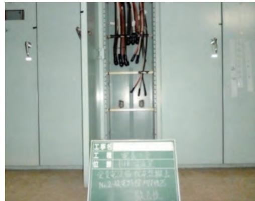
写真4 電線ケーブル接続状況（更新時）
