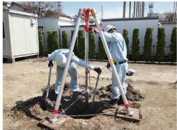
写真4 人力による引抜き工法
