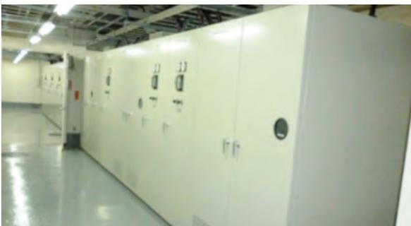
写真2 高圧受電盤の設置状況（新設）
