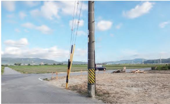
写真1 打込アンカ施設
