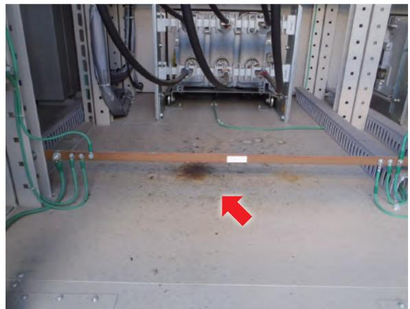
写真3 盤内床部の錆
