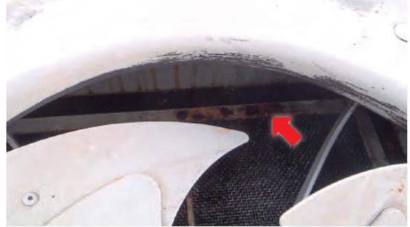
写真5 換気扇部の錆
