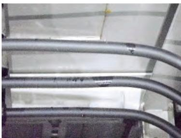
写真16 天井換気扇下部水滴痕
