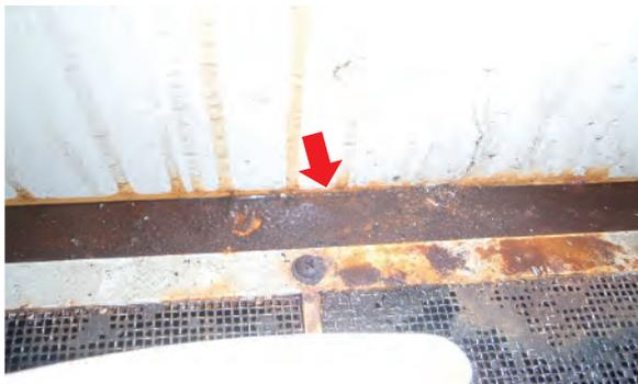
写真6 換気扇部の錆
