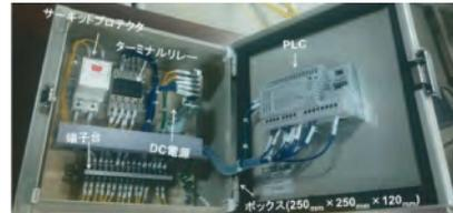
図4 低コスト型 APFC試作機のハードウェア構成
