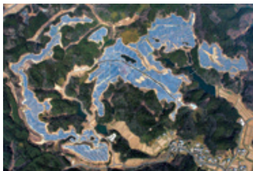
△上空から見た発電所全景
