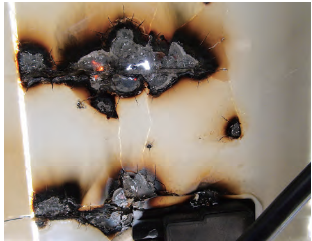
図4 産総研で発生したモジュールの深刻なトラブルの例 (モジュール裏面のインターコネクタ接続部が激しく焼損し、その一部は日中500℃以上になっていた。表面ガラスは全損している)
