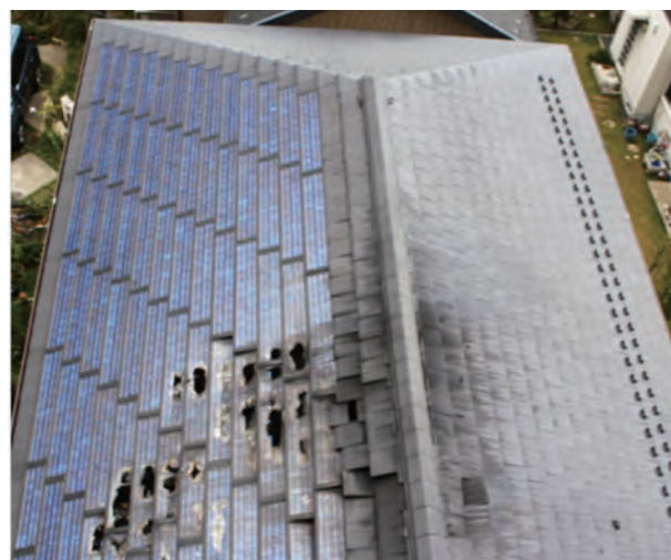
図3 2011年9月に発生した住宅用PVの火災事故 (写真提供: 船橋市消防局)
