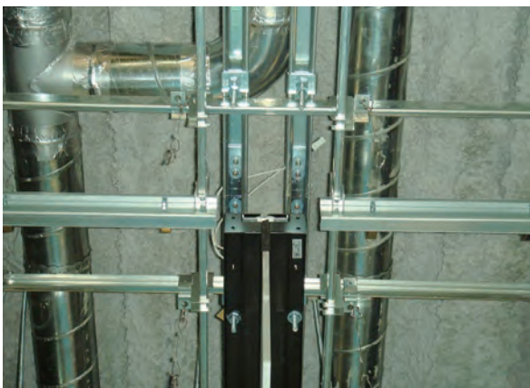
写真6 導光板照明器具取付状況
