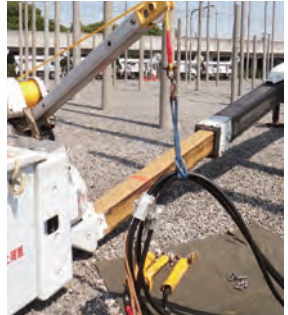
吊り上げ準備
