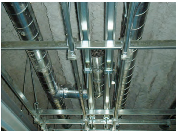
写真5 照明器具取付下地金物
