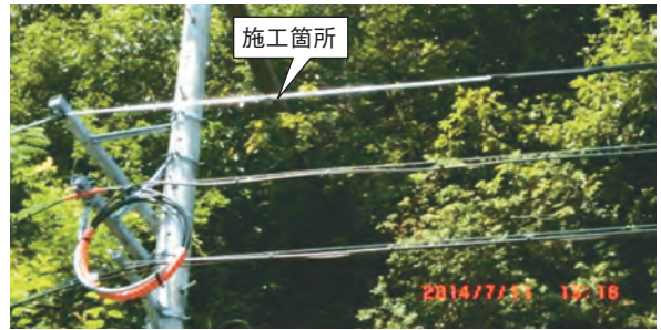
写真5 現地施工状況 (一番手前のケーブル2m程度施工)
