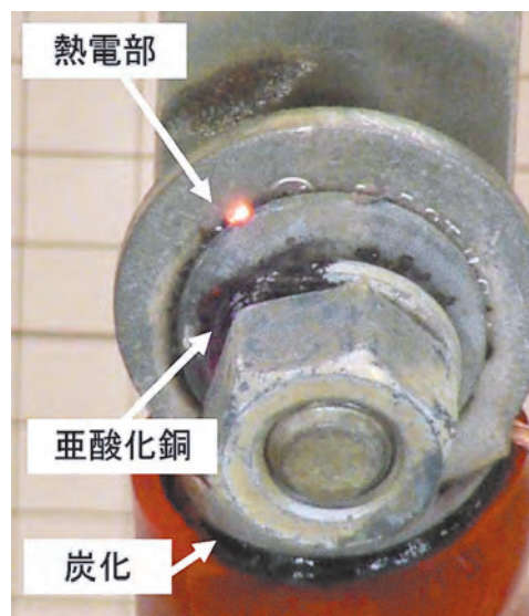
写真2-2 赤熱現象発生時の端子部の様子
