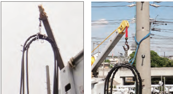
吊上げ状況 ケーブル巻付ハンガによる支持 写真12 使用状況
