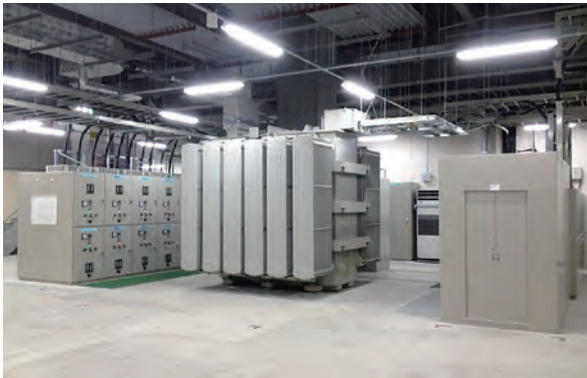
写真2 特高受変電設備（地階）
