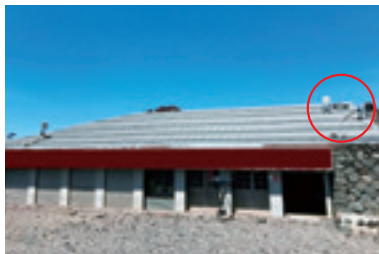
山小屋の屋根に設置したアンテナ(赤丸)
