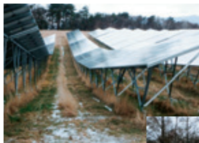
△起伏に合わせて設置したパネル
