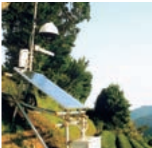
地すべり監視カメラ
