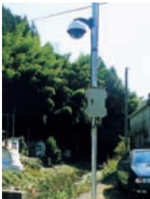
河川氾濫監視カメラ
