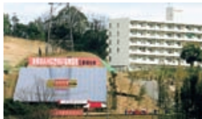
太陽光発電システム
