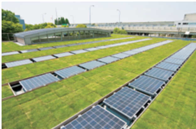
ビジターセンター屋上緑化とソーラーパネル
