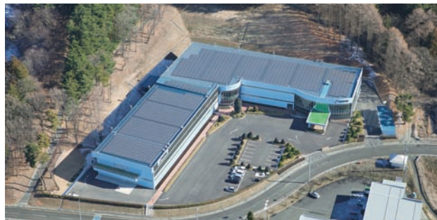
△上空より建屋屋上
