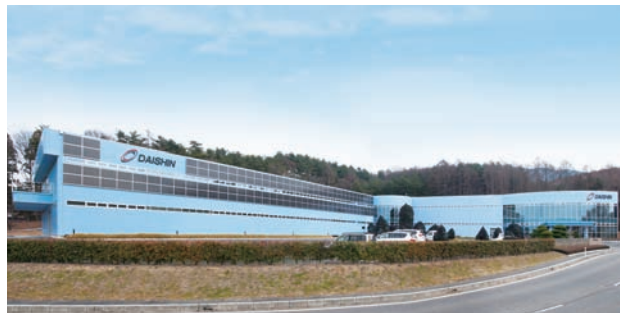
△工場建屋正面
