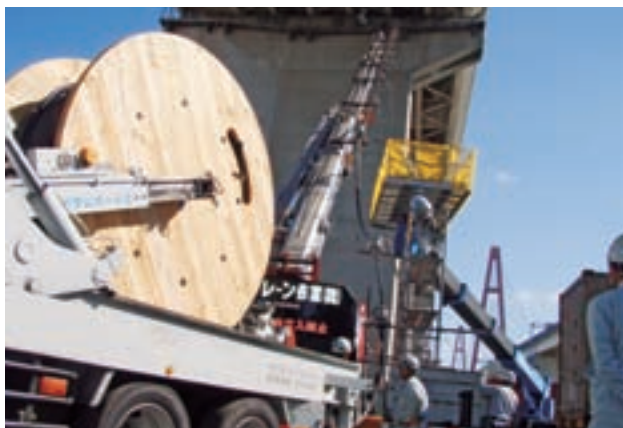
△新ケーブル敷設状況
