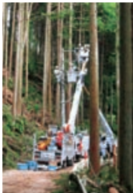
災害復旧作業の様子(台風15号)▷
