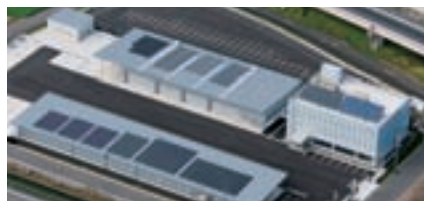
◁屋上に設置された太陽光パネル
