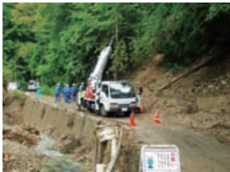
△災害復旧作業の様子(台風12号)
