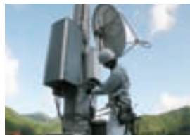
◁モバイルエンジニアリング部の復旧作業の様子
