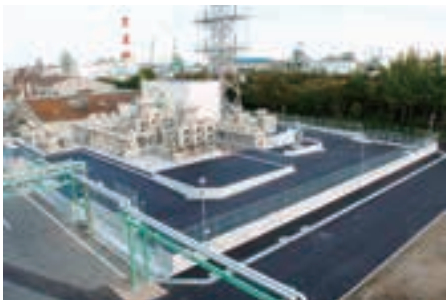
△旭硝子(株)千葉工場 特別高圧電気受変電設備
