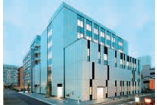
△総合上飯田第一病院南館
