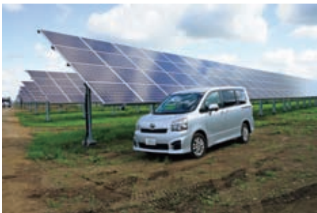
△積雪に備えて背が高く、日射角度も考慮したパネル
