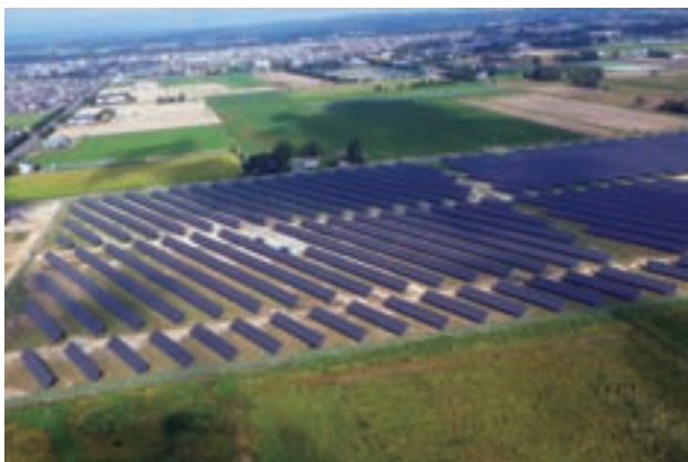
△トーエネック太陽光恵庭発電所
