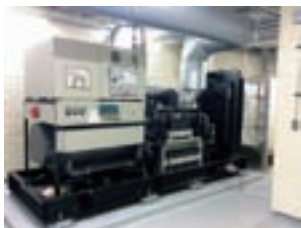
△非常用発電機
