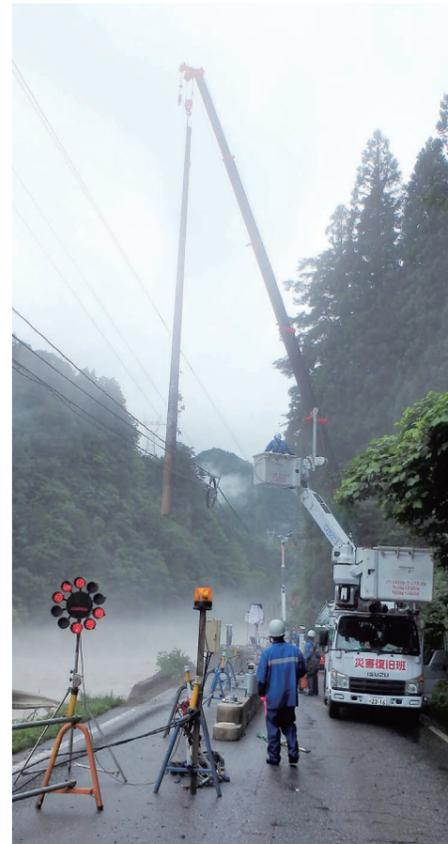
▲道路が崩落し根元がむき出しになった電柱を抜柱する様子
