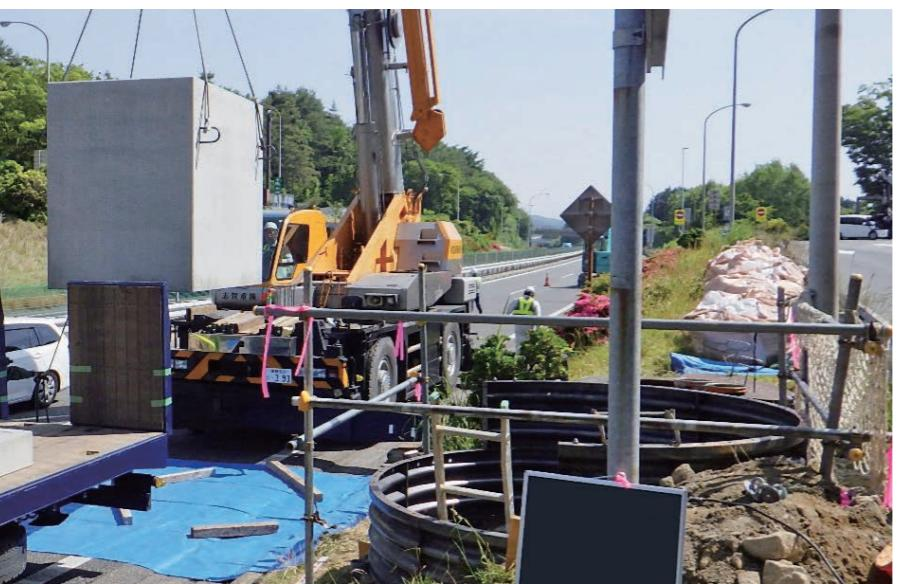
今回の工事では、地中に仮設の電源ルートを確保しました。電源ケーブルを地中に通す管路の設置にあたり「シールドマシン」と呼ばれる円筒形の掘削機で地中を掘り進め、同時に掘削した穴に鋼管を次々と送り込んで管路を造っていく「推進工法」で工事を行いました。具体的には、座光寺下り線PA内と下り線PA付近の路肩までの区間延長15mにわたり、深さ約1.4mの位置（掘削深は地下3.5m）に延長12mのトンネルを開け、内部にφ750mmの管路を設置して施設電源・通信設備用のケーブルを仮設しま
