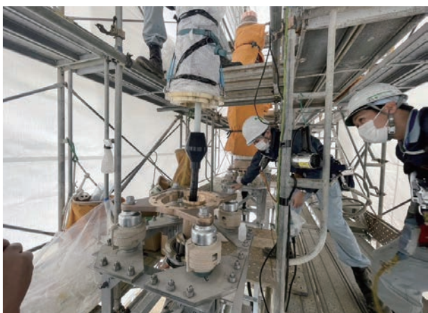
写真14 110kVケーブル気中端末工事
