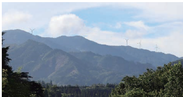
写真2 風力発電所 全景
