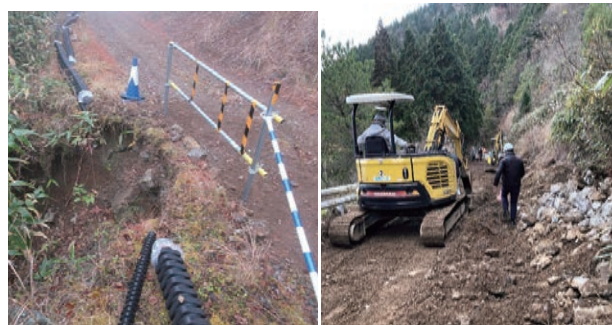
写真6 山岳地の埋設管路(新設)工事
