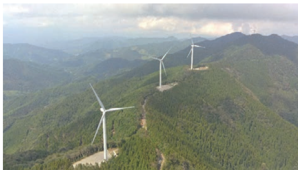
写真1 風力発電所 全景
