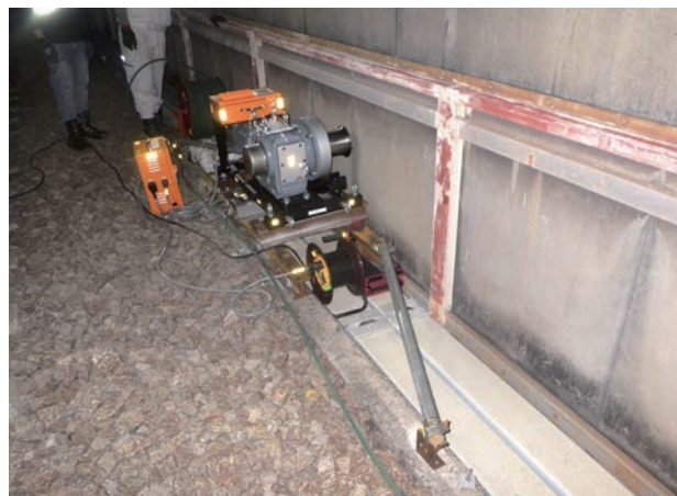
写真８ ウインチ設置状況
