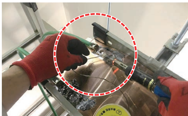
写真3 銅板とIV電線の半田接続状況（1）
