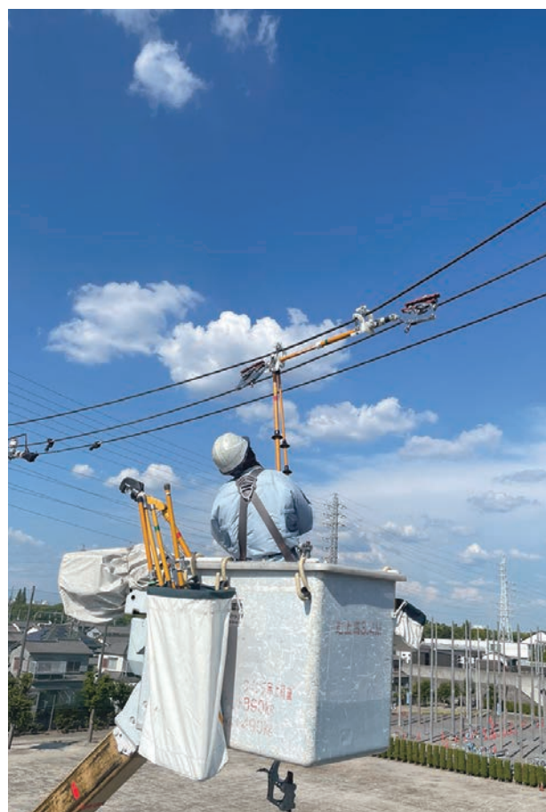
【写真1】 柱間切分工具Ⅰ型
