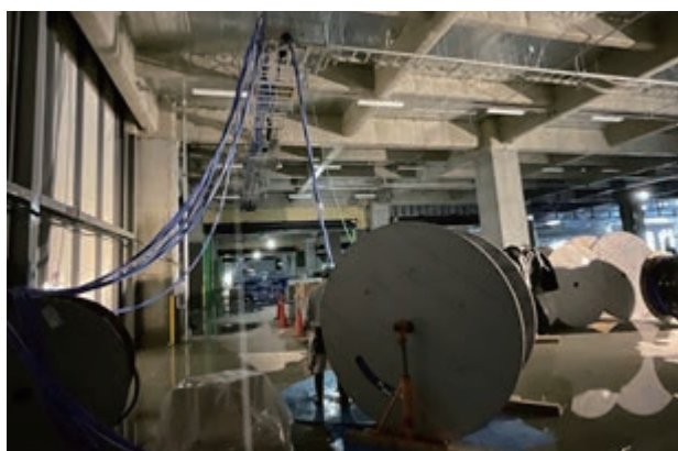
写真2 アルミケーブル敷設時の様子
