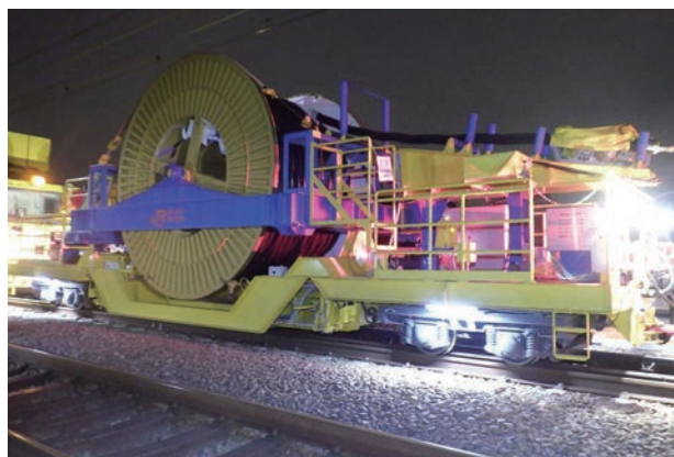
写真4 ケーブル延線装置車
