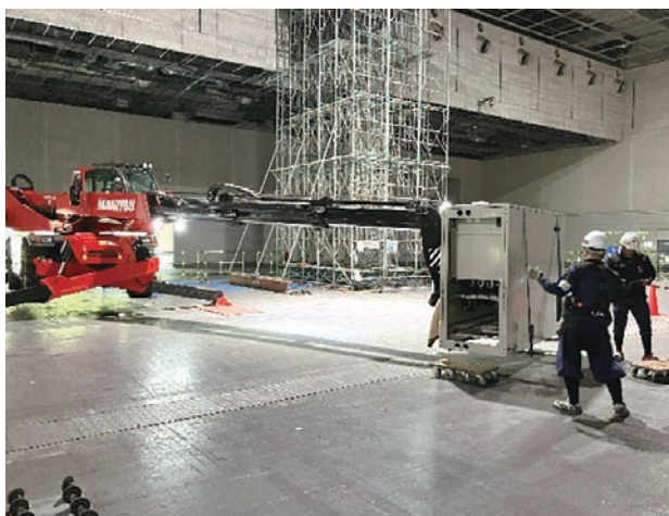
写真8 台車を用いたブームへの設置状況
