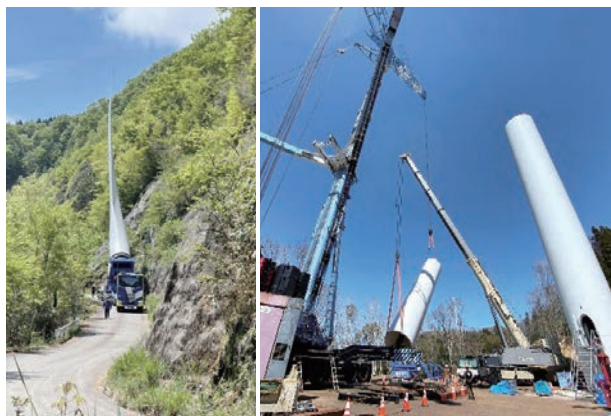
写真8 土木EPCによる風車機器搬入
