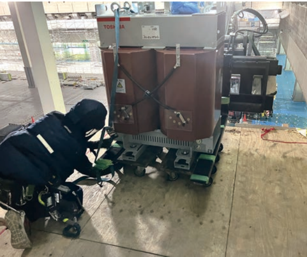
写真7 搬入架台上での荷受け状況
