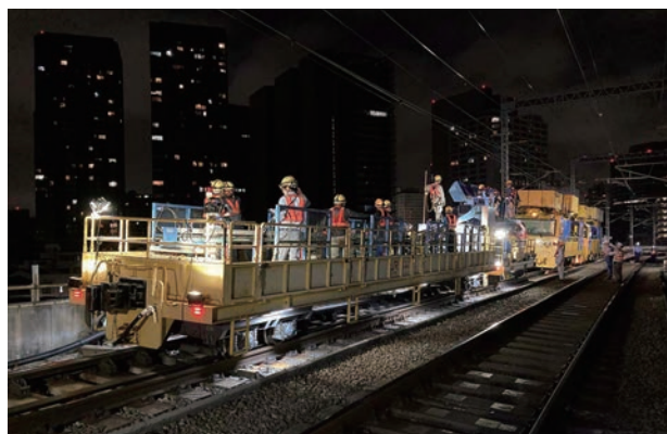
写真3 撤去ケーブル運搬車
