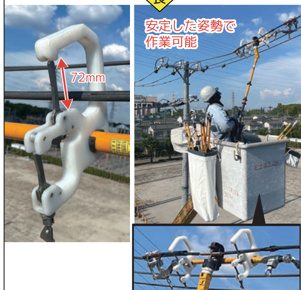
【写真5】 柱間切分工具Ⅱ型の作業の状況
