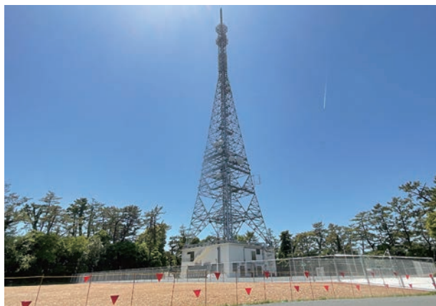
写真1 今回新設建屋（鉄塔含む）
