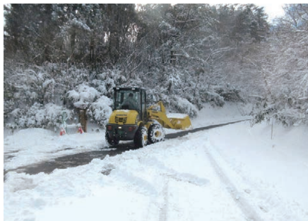
写真7 冬季における現場への通行路
