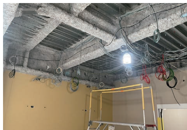
写真3: ユニットケーブル施工状況
