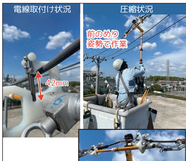
【写真4】 柱間切分工具Ⅰ型の作業の状況
