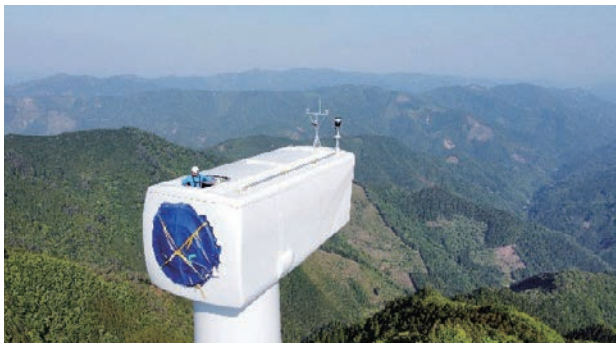
写真13 風車上部 航空障害灯設置
