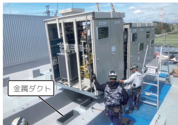
写真2 キュービクル下部ダクトの様子
