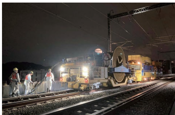
写真7 ケーブルの落とし込み（敷設）作業
