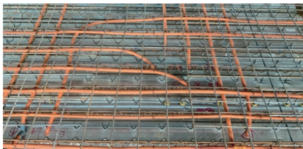
写真1 打込配管の様子
