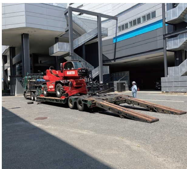
写真3 テレハンドラの運搬状況
