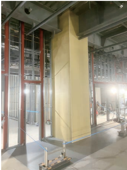
写真 (1) 盤搬入前の床仕上げ状況
