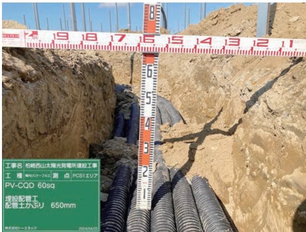
写真6 配管埋設状況
