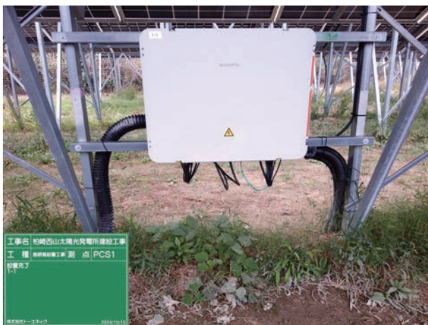
写真7 ケーブル露出防止対策状況
