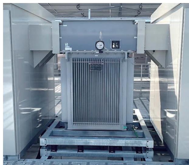
写真3 変圧器据付状況
