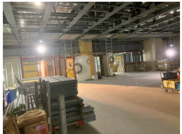
写真 (2) LGS工事前に盤の設置、ケーブルラックを設置した状況
