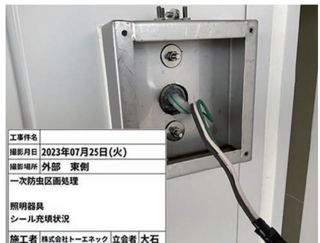
写真1 一次防虫区画処理の状況（照明器具）
