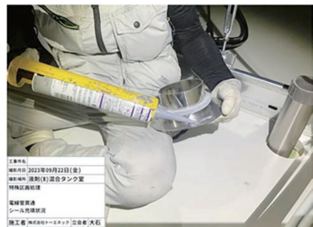
写真3 二次防虫区画処理の状況
