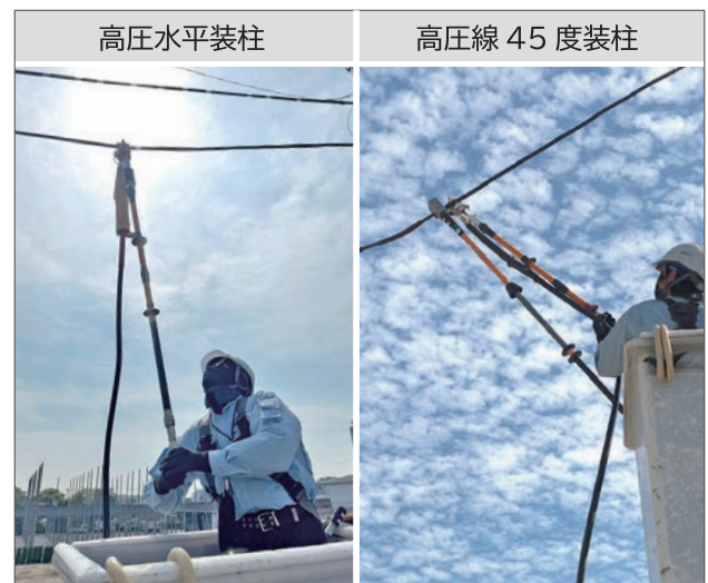
写真9 各種装柱への検証状況
