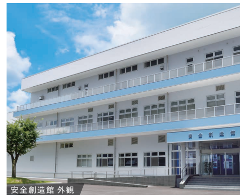
安全創造館 外観
