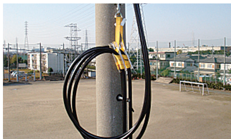
仮送電用ケーブルの保持用として使用した例
