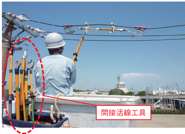
写真1 柱間切分工法の作業風景
