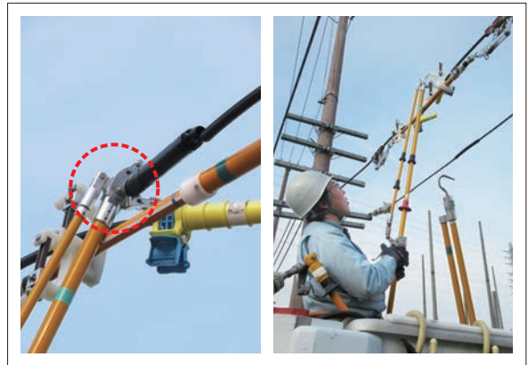
写真9 ヤットコタイプ使用時の作業検証状況
