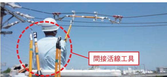
写真11 マルチヤットコ使用時の作業風景
