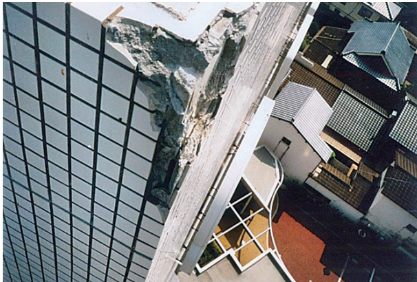
図 20 ビル屋上コーナー部への直撃雷痕跡
