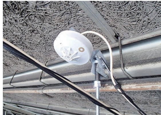
写真3 感知器取付金物 (感知器取付時)
