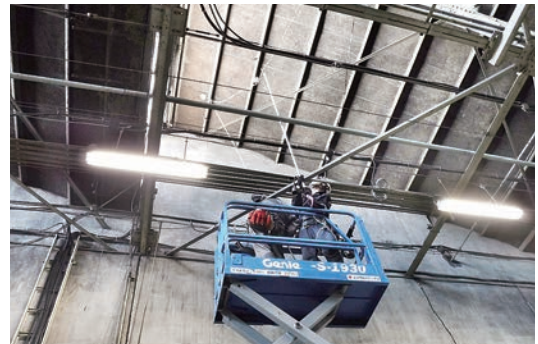
写真8 配線（南北）布設状況
