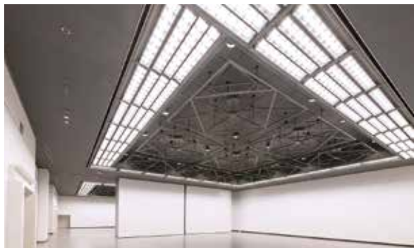
写真5 リニューアルユニット取付状況
