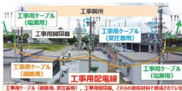
写真1 工事用配電線の敷設・撤収工事
