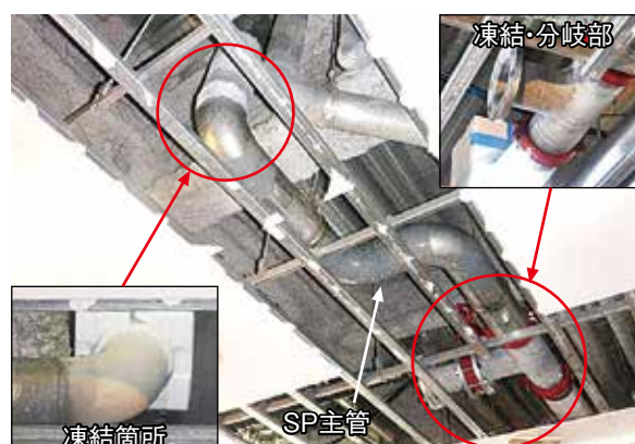
写真8 凍結工法による分岐
