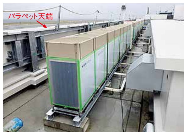
写真3 空調屋外機とパラペット
