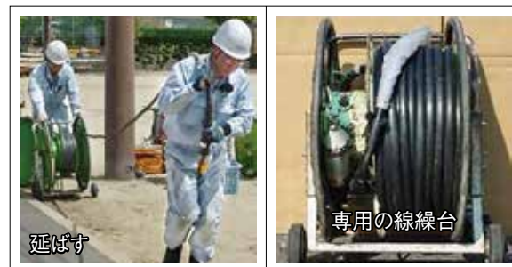
写真2 ケーブルを延ばす作業
