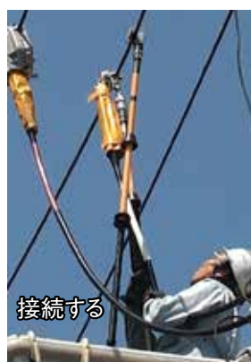
写真5 ケーブルを接続する作業
