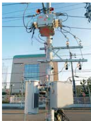
写真2 簡易SC装置の装柱の様子
