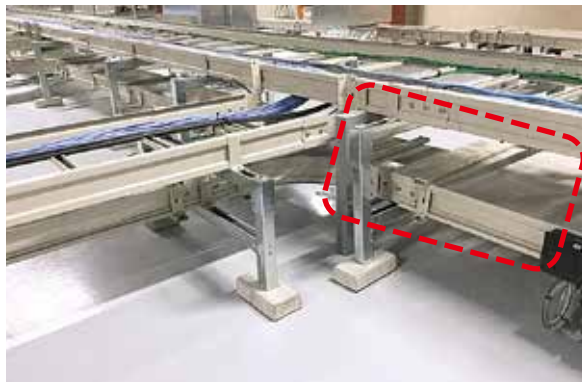
写真2 ケーブルラック下段の上下蓋付施工と上段音響ケーブルのノイズ低減処置状況
