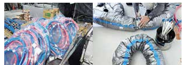
(a)給水・給湯管の搬入 (b) 空調ダクトの組立
