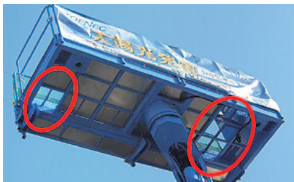
写真11 作業床改良後
