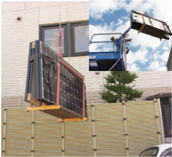
写真9 専用治具によるパネル吊上げ状況
