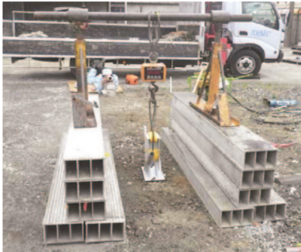
写真3 引抜試験状況
