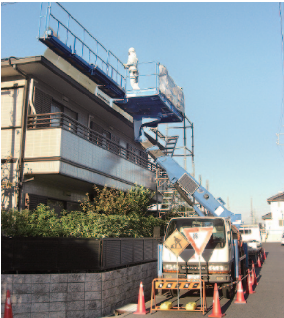
写真4 プラットフォーム部の屋根設置状況
