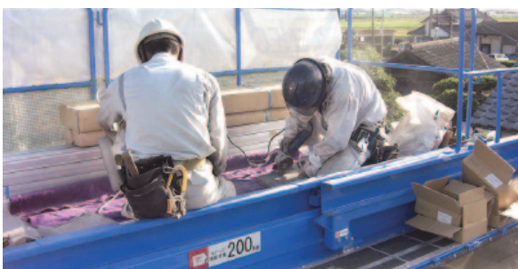
写真6 屋根近傍における瓦の加工等の軽作業
