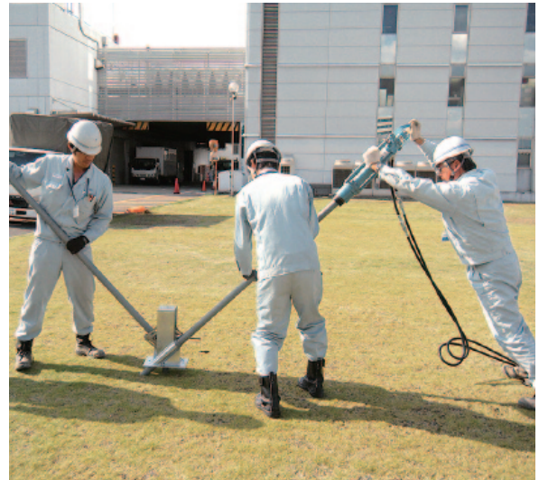
写真5 支持鋼管パイプ打込み状況
