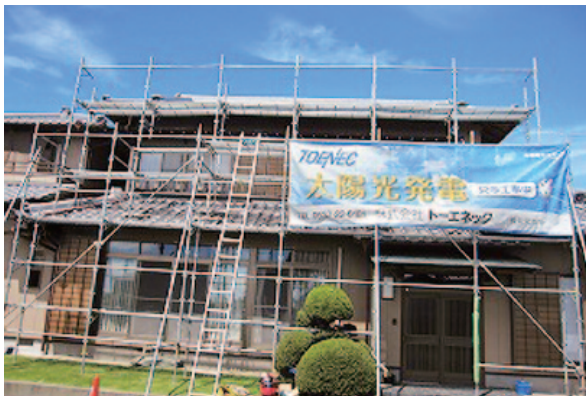
写真1 仮設足場設置状況
