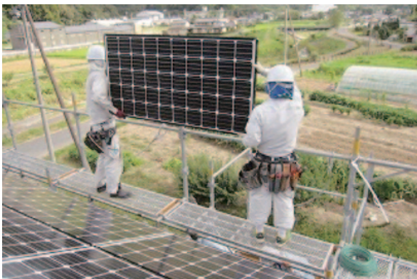
写真2 仮設足場上での太陽光パネル取扱い状況
