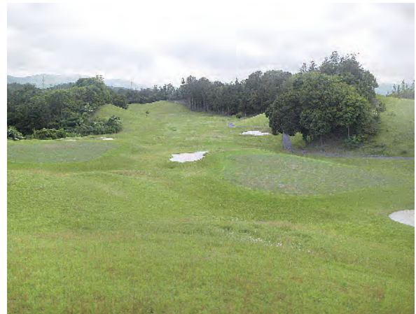
写真1 施工前の状況
