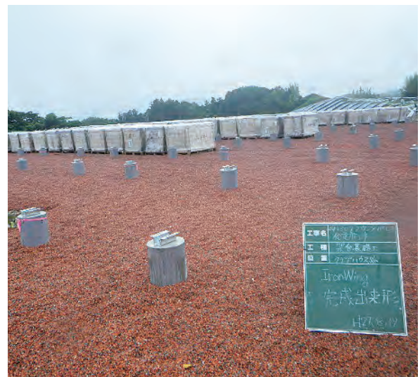
写真5 土間コンを活かした基礎
