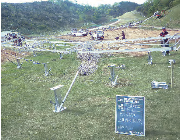
写真2 治具を用いたFX基鋼管礎施打設状況
