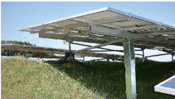
写真3 基礎モジュール設置状況
