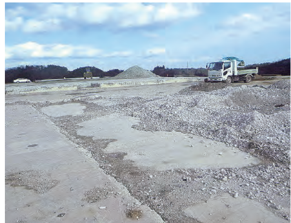
写真4 クラブハウス撤去後 土間コン残置状況
