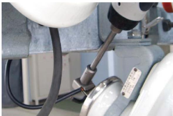
写真11 接地端子締付けの様子
