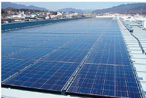
写真1 屋根置き太陽光パネル
