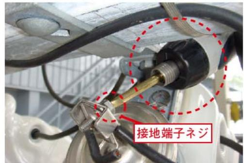
写真9 干渉して施工不能
