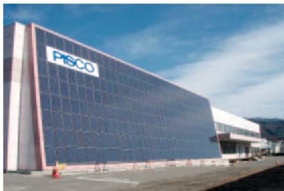
写真2 外壁取付け太陽光パネル
