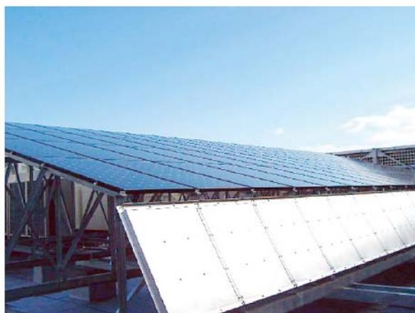
写真4 垂直設置裏面へ反射させる反射板
