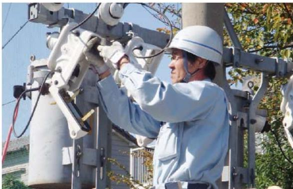
写真1 PC端子接続作業の様子
