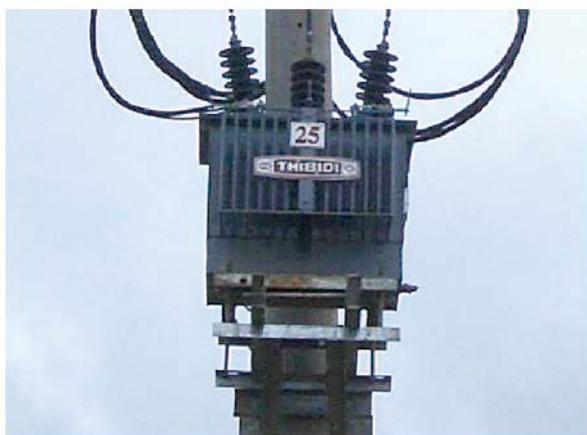
写真3 柱上変圧器 (25kVA) 写真
