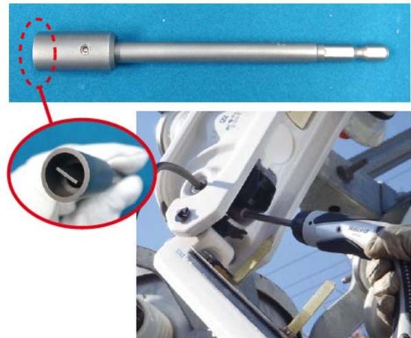
写真10 PC端子用ビットおよび施工状況
