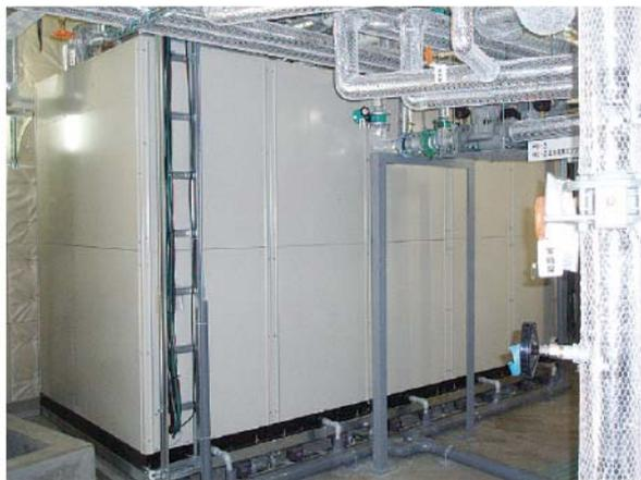
写真4 水熱源ヒートポンプ（機械室）
