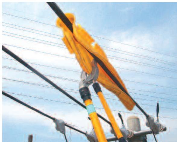
写真5 間接用線力バーを取付ける様子
