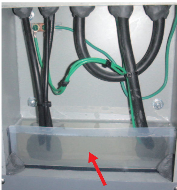
写真7 防臭区画処理
