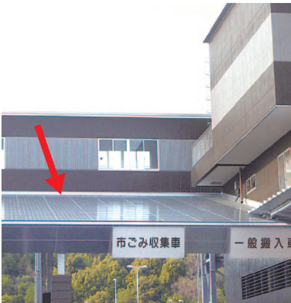
写真4 太陽光発電20kW
