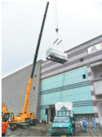
写真1 130tonクレーンによる冷凍機の搬入
