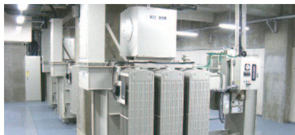
写真7 特高受変電設備 (更新後 ガス絶縁式DS)
