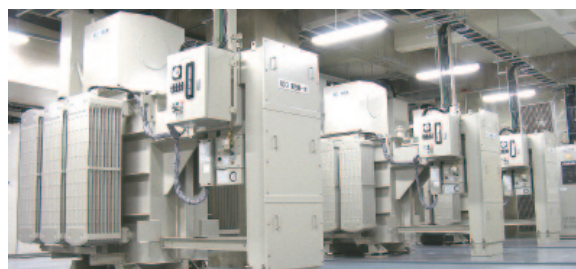
写真8 SNW特高受変電設備 (更新後)
