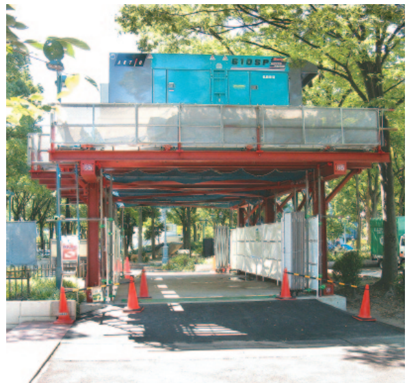
写真3 非常用発電機設備（仮設）
