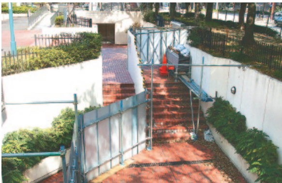
写真1 マシンハッチ設置場所（地上）
