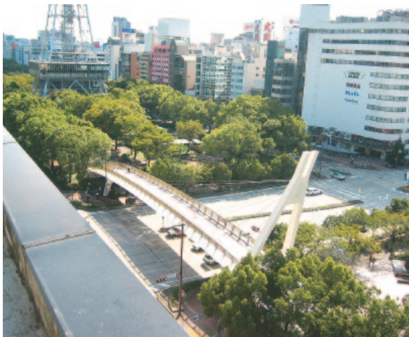
セントラルパーク地上公園部
