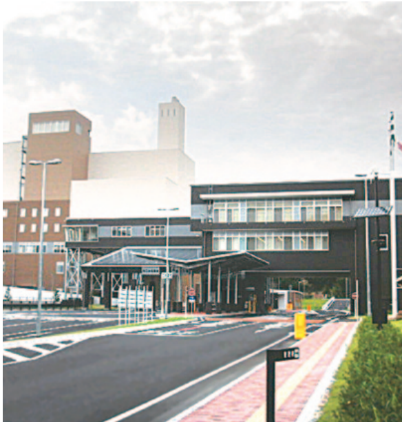
写真5 工場棟（左奥）・管理計量棟
