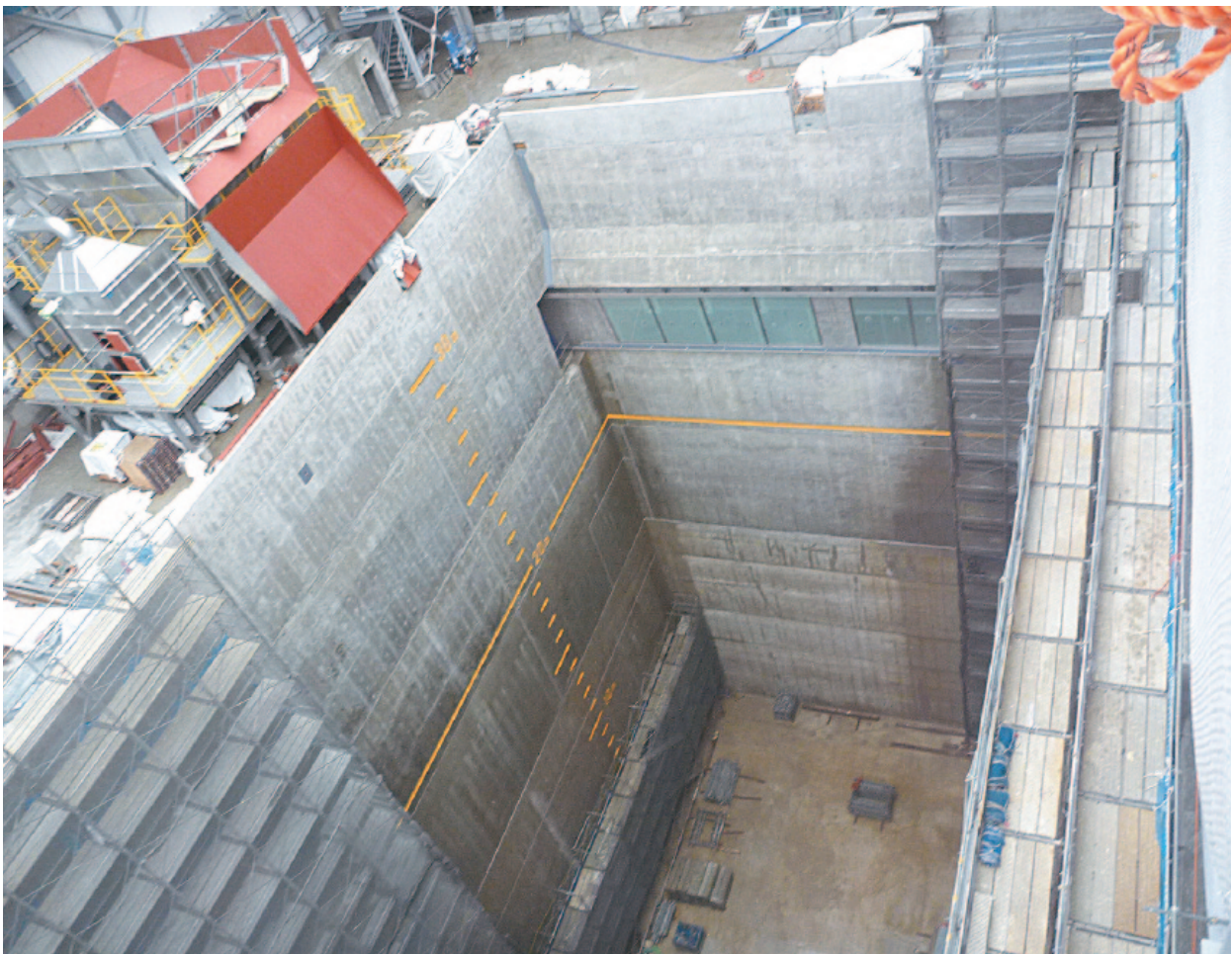
写真6 ごみピット・ごみ投入ホッパー
