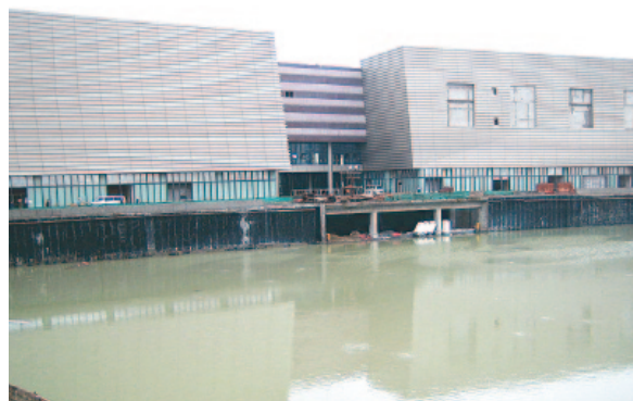
写真3 B1F浸水被害の様子 (写真はB1Fの床上600mmまで浸水している状態。B2Fには完全に水が入っている。)
