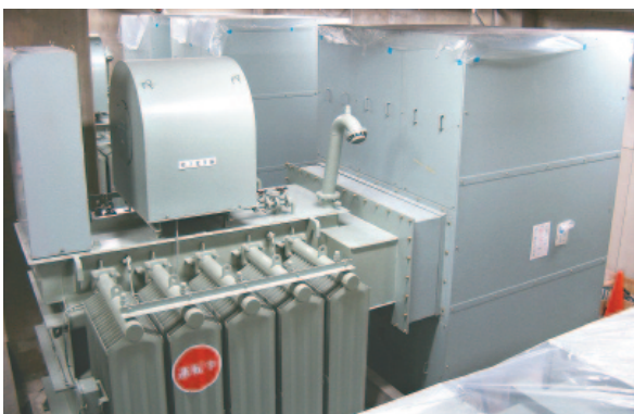
写真6 特高受変電設備 (更新前 空気絶縁式LDS)
