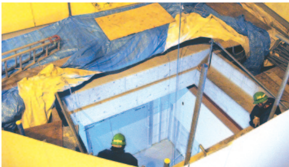
写真2 マシンハッチ開口作業（B1F床）
