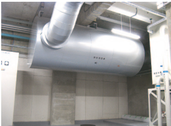
写真5 大口径サイレンサー (更新後)
