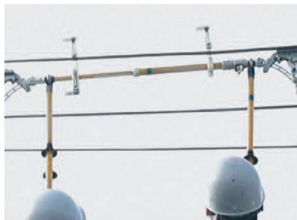
写真18 水平装柱に柱間切分工具を取付けている状況
