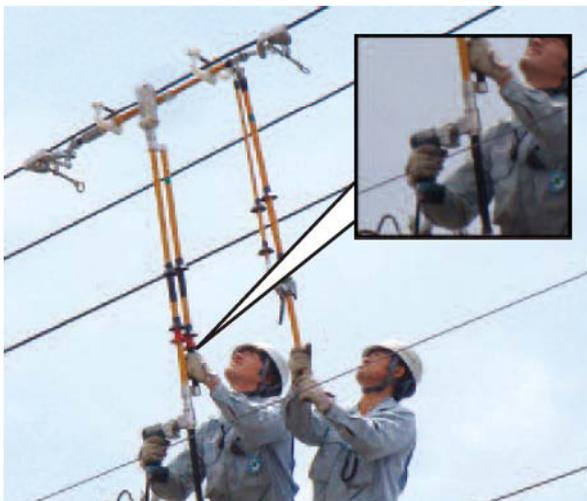
写真13 充電式回転工具を使用して作業している状況
