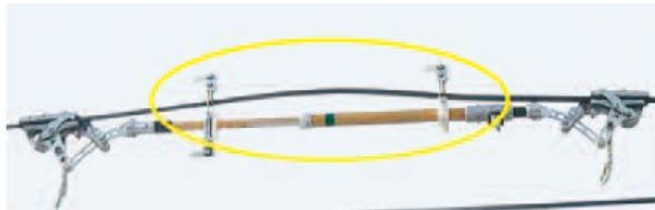
写真19 電線切断時の縁を作った状況
