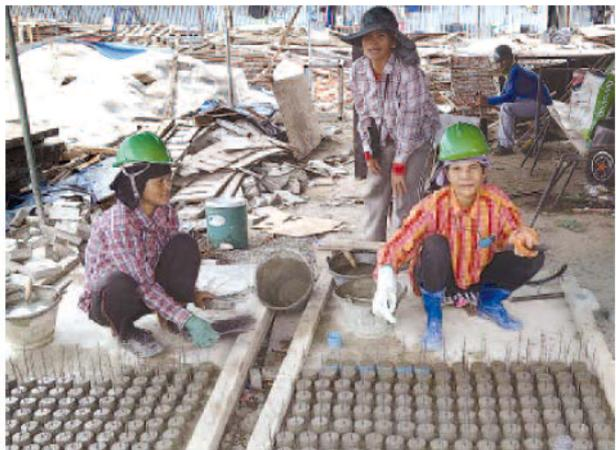
写真2 鉄筋スパーサーを作る女性ワーカー
