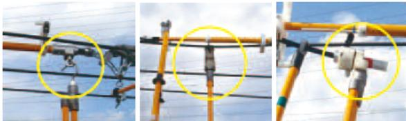
ドライブフック 電線カッター 先端皮剥ぎ磨き器
