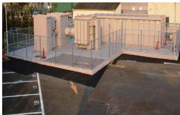
写真1 特高受変電設備の設置状況
