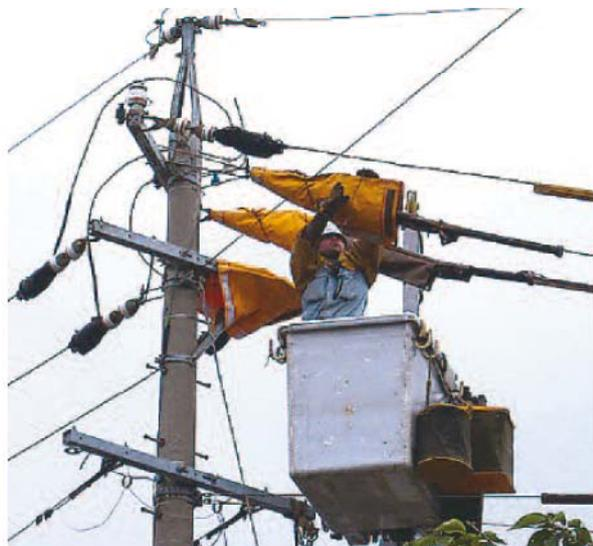
写真1 高圧充電部に接近しての直接活線作業
