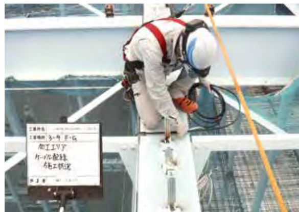
写真1 鉄骨梁上部における配線状況
