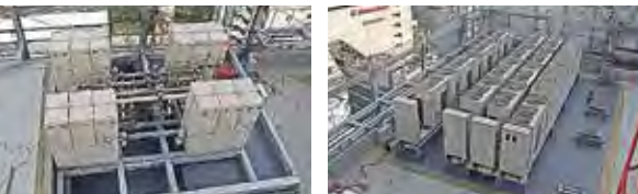
写真5 Safie GO 設置及び屋上の状況
