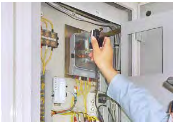
写真3 社内検査の様子（現場側）
