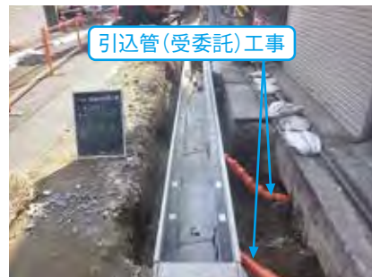
写真6 同時工事の様子
