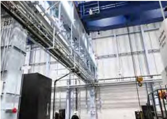
写真3 天井クレーン用鉄骨下の設備共用架台
