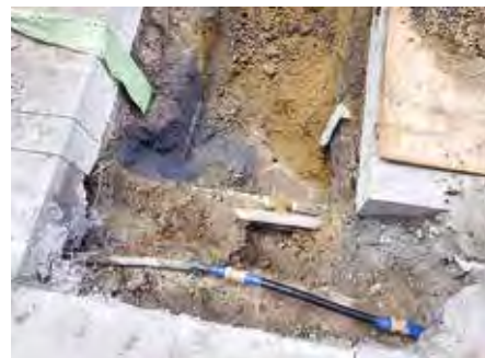
写真7 トラブル確認
