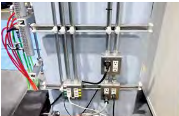
写真4 柱廻りの配管支持
