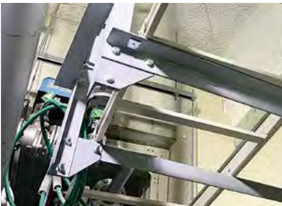
写真2 耐震鋼材相互の2点固定状況
