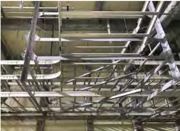
写真1 受変電内の耐震支持
