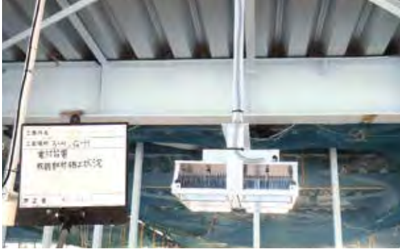
写真2 高天井の照明取付け状況 (仮設照明利用)
