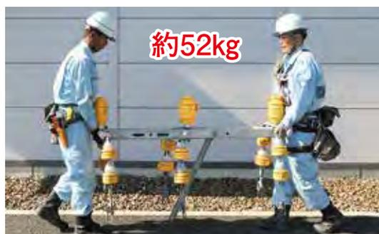
写真4 大型化・重量化した資材の運搬
