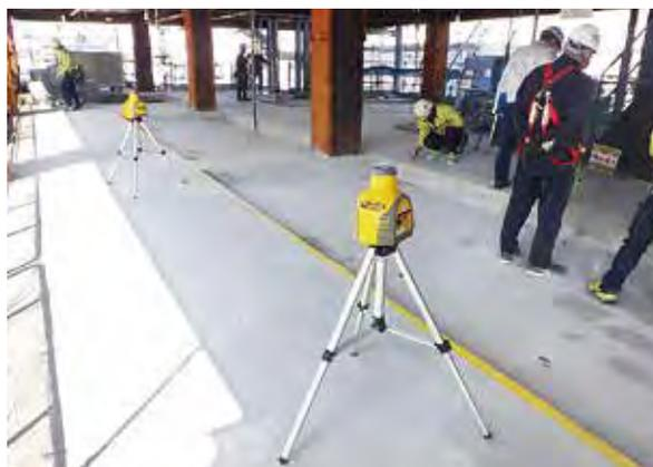
写真1 QMLによる墨出し作業
