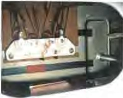
写真3 タップ電圧を6300Vに設定
