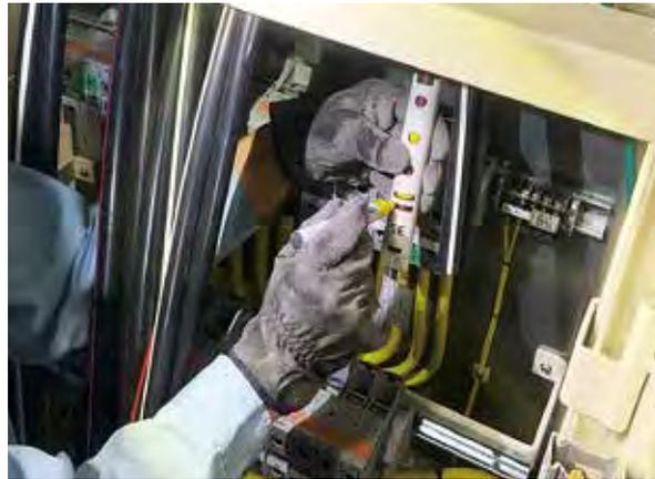
写真3 専用ゲージによる採寸作業
