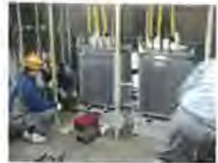
写真6 新規変圧器設置作業状況
