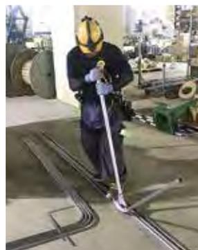
写真1 金属製電線管加工状況
