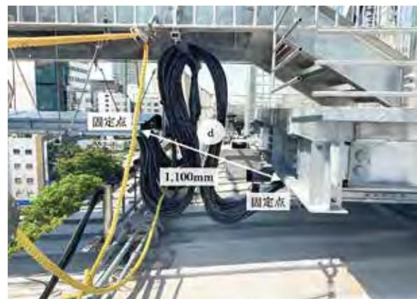
写真3 免震施工 (写真は施工中のもの)
