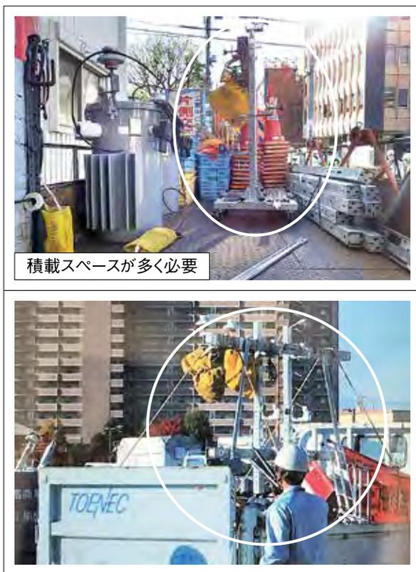
写真8 専用台車の積載状態
