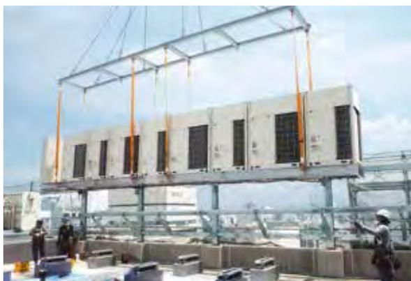
写真3 室外機ユニットの搬入状況
