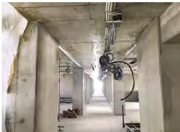
写真2 先付けダクト取付状況
