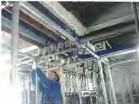
写真4 フレームパイプ取外状況
