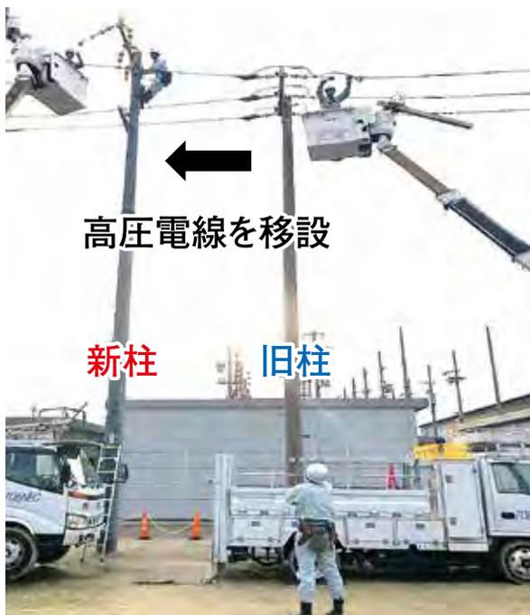
写真1 高圧移線工事の現場
