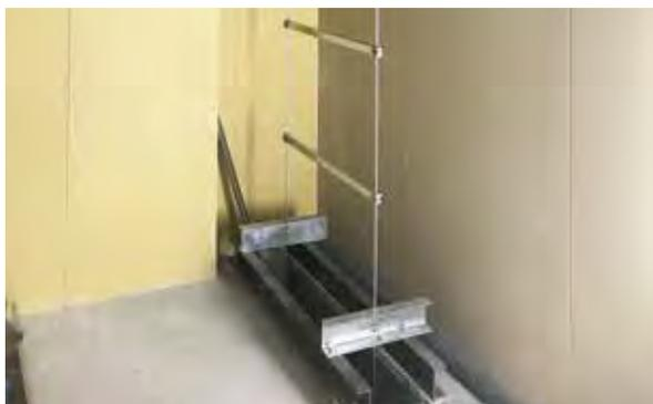
写真2 ラダーラックの施工状況
