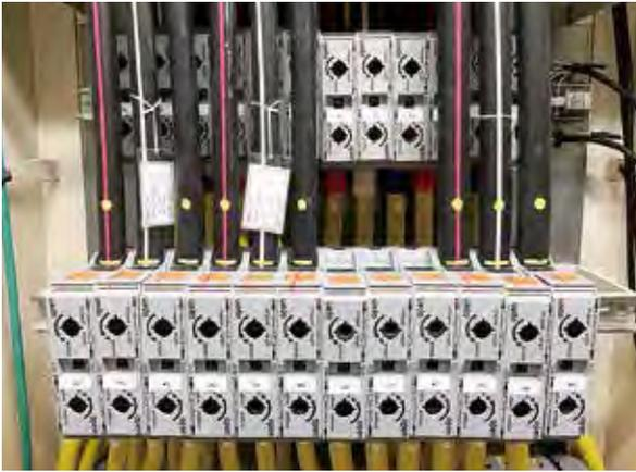
写真2 電源分岐盤のダイレクト結線端子台
