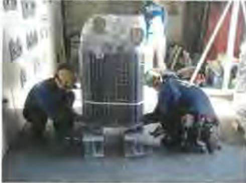
写真2 変圧器架台取付状況
