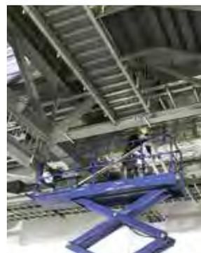
写真2 金属製電線管取付状況
