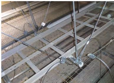
写真3 「ワイヤ振れ止め工法」の施工例
