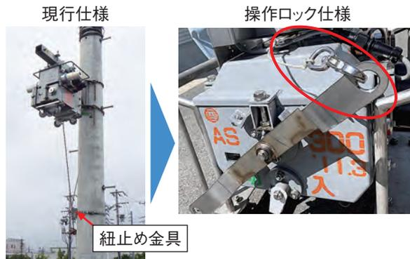
写真4 開閉器操作ロックの簡易化
