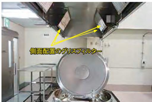
写真2 グリスフィルター側面設置状況
