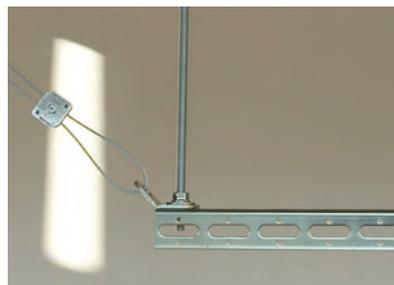
写真2 採用したワイヤ振れ止め材
