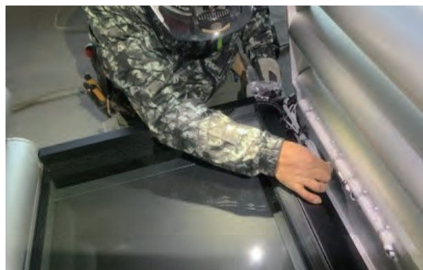
写真5：サッシ部分に配線
