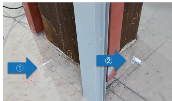
写真11 位置タグ設置方法改善（タグ2枚・柱面に垂直）
