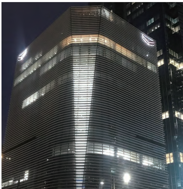
写真3：完成時の点灯状況
