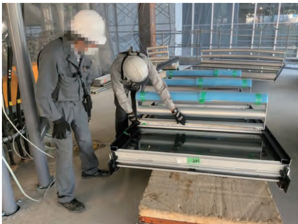
写真6：器具片付け状況の確認
