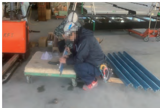
写真4：ルーバーへ照明器具取付け
