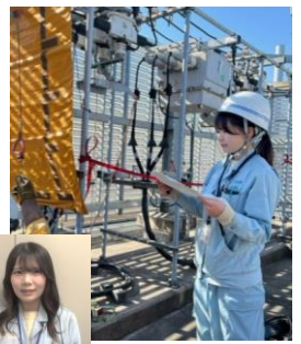
名古屋支店 配電部 地中線グループ 田村 明香里
