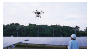
ELドローン測定の様子
