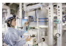
空調管設備工事
