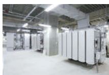
電気設備工事
