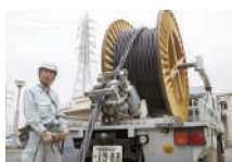
電力供給設備工事
