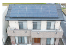
省エネ住宅設備工事
