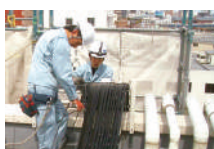
情報通信工事
