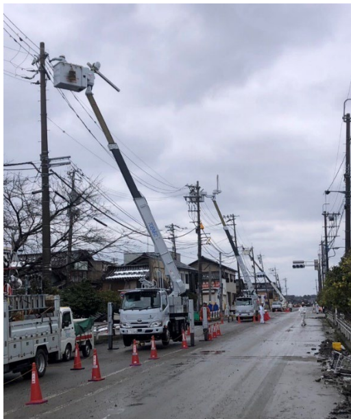
配電設備復旧作業の様子
