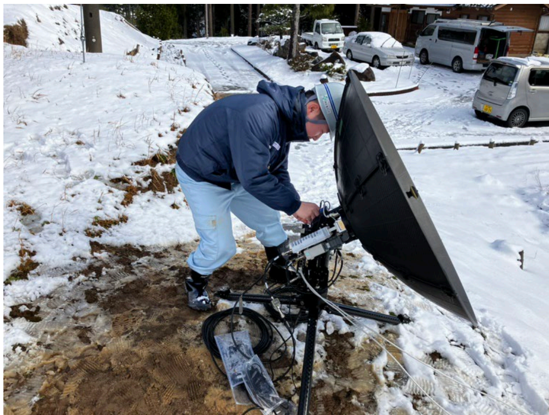
通信設備復旧作業の様子
