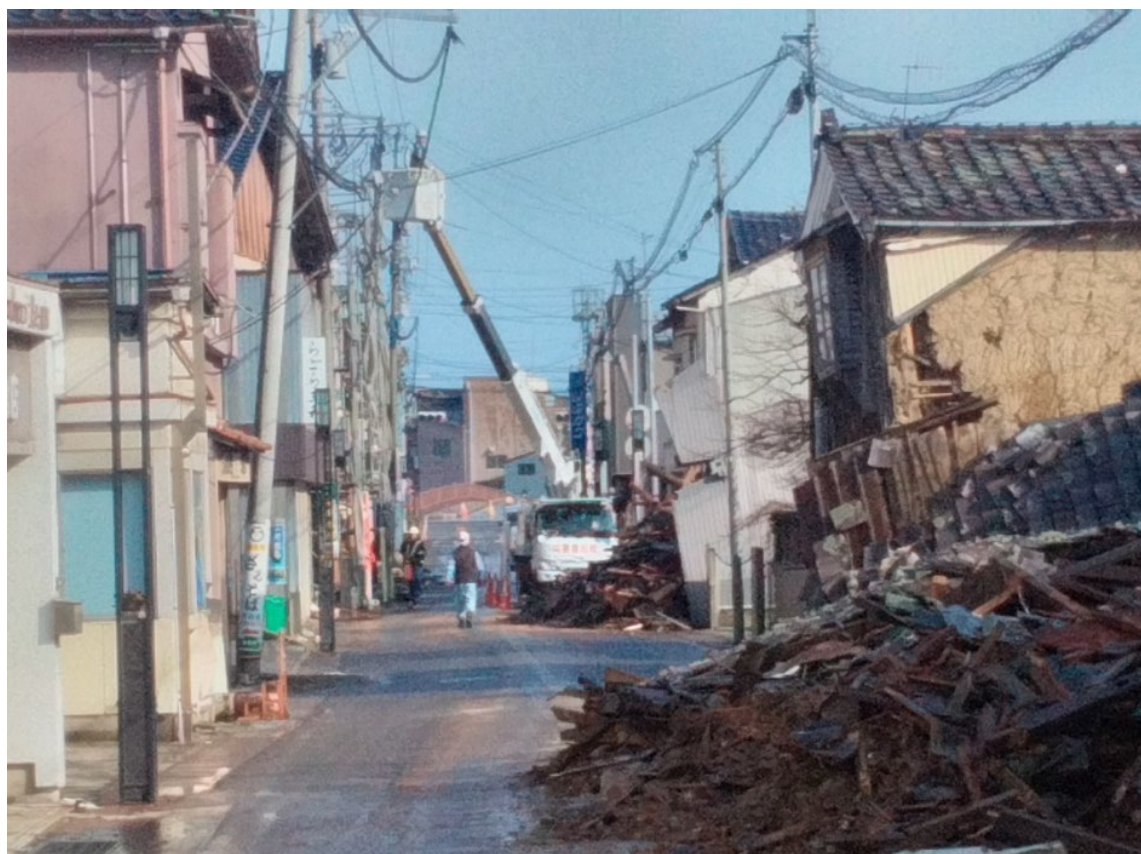
配電設備復旧作業の様子
