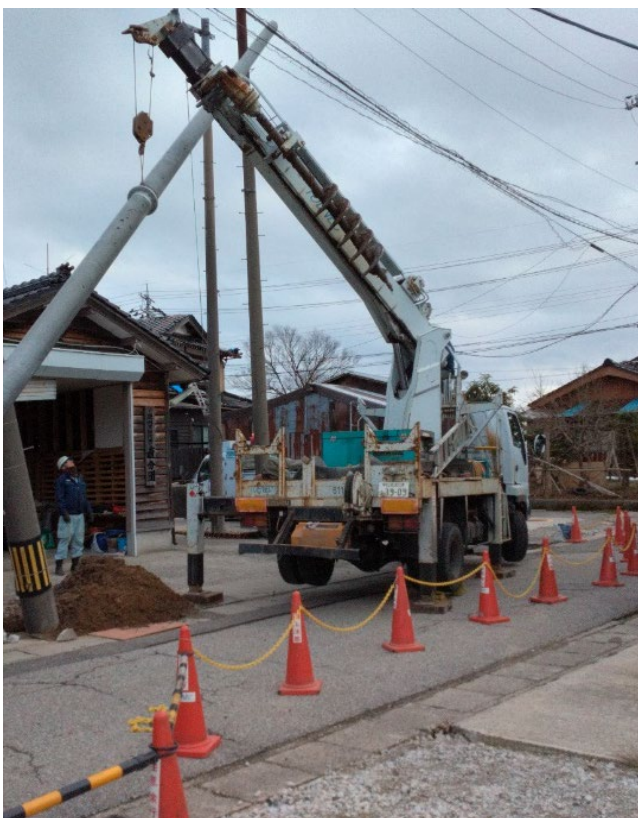
配電設備復旧作業の様子
