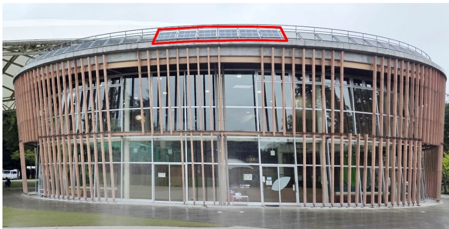
外周柵に設置
