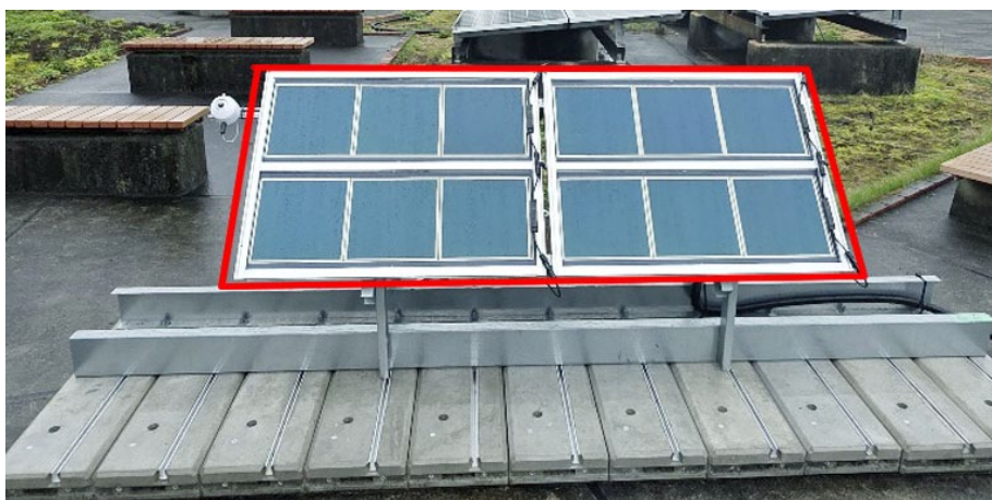
置き基礎架台にて設置
