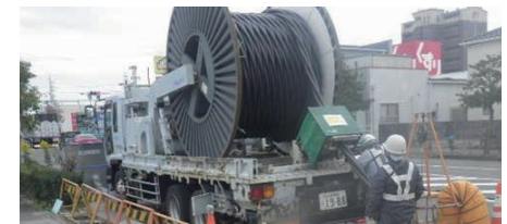
ケーブル布設の様子
