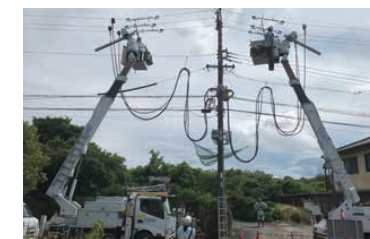
間接活線工法による作業の様子
