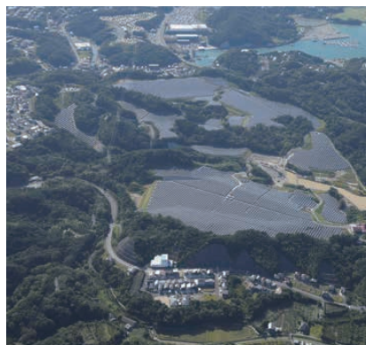
和歌山白浜太陽光発電所新設工事
