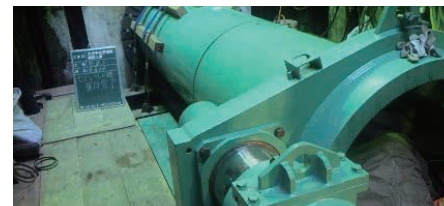
推進工法による掘削の様子
