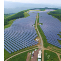
長門牧場メガソーラー 発電所(長野)
