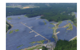
② 太陽光発電設備
