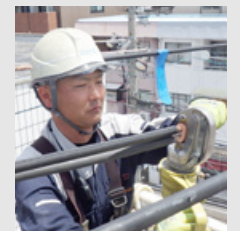
名古屋支店大幸営業所 配電工事グループ
