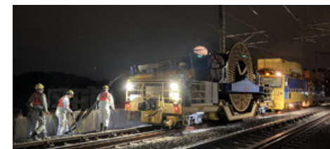
新幹線地中送電線(綱島・大崎線)取替工事
