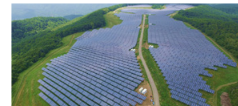
長門牧場メガソーラー発電所
