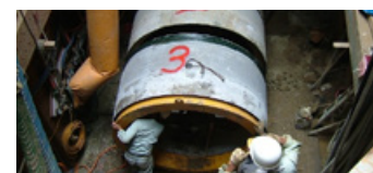
2007 台湾電力地中線工事
