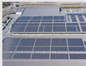
①太陽光発電設備工事
