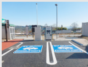
②EV充電設備工事
