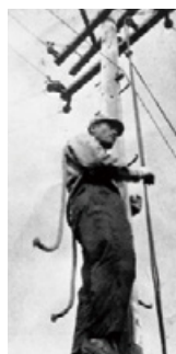
配電線工事 (引込線作業)
