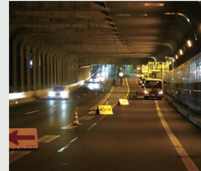
無線通信補助設備デジタル化工事
