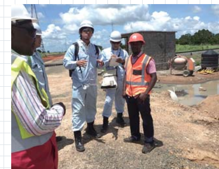
モザンビークでの工事打合せの様子
