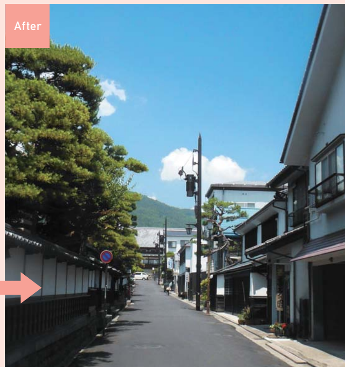
配電線の地中化工事後
