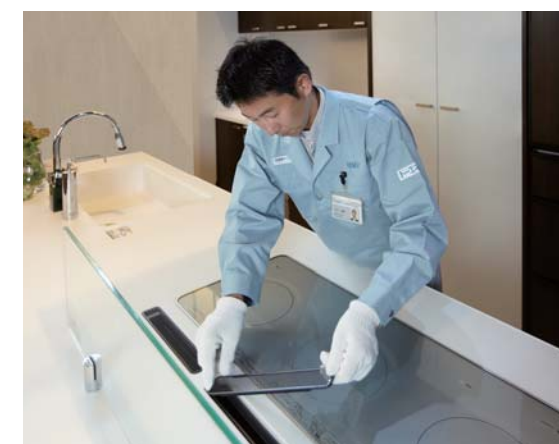
IHクッキングヒーター設置工事
