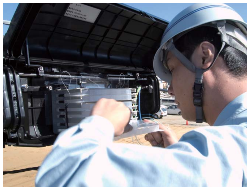
FTTH光ケーブル接続作業
