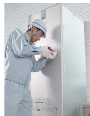
エコキュート設置工事
