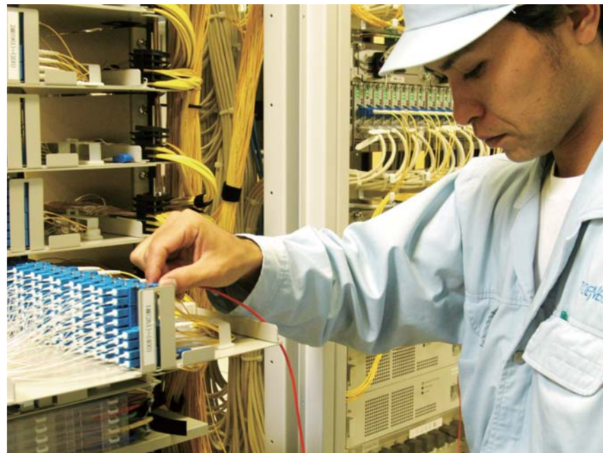
回線接続確認作業
