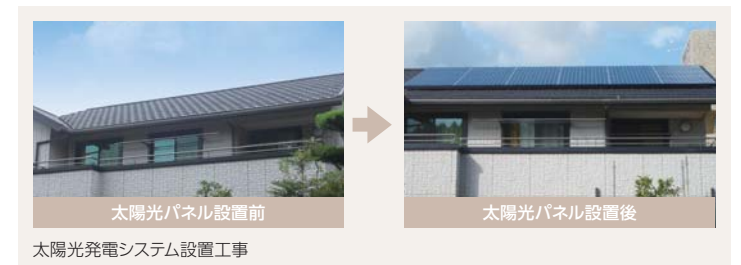
太陽光発電システム設置工事
