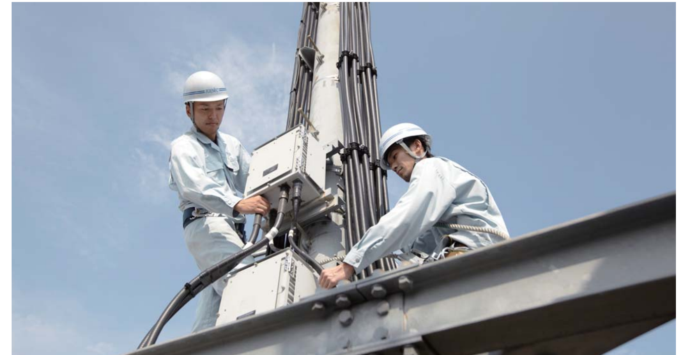
移動体通信基地局の確認作業
