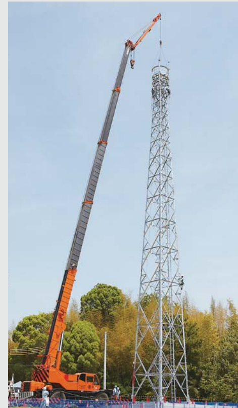
移動体通信基地局の建設
