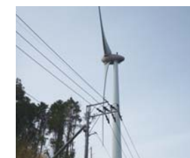
自営送電線建設工事
