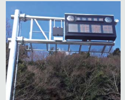
非常用設備更新工事
