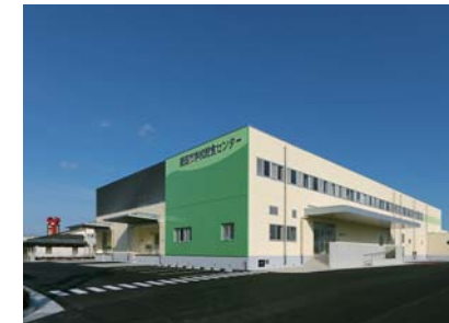
愛西市学校給食センター(愛知県愛西市)
