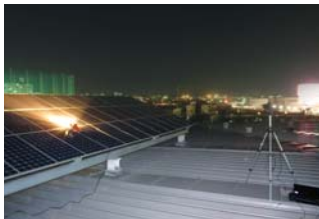
太陽光発電パネルの現地EL測定
