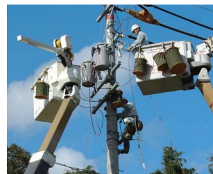
変圧器揚替工事
