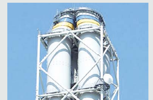
集合煙突上部架台に設置された「多重無線パラボラアンテナ」
