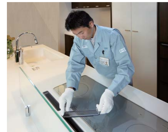
IHクッキングヒーター設置工事
