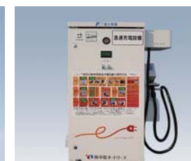
電気自動車等の急速充電器設置工事
