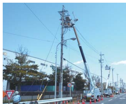
電線張替工事
