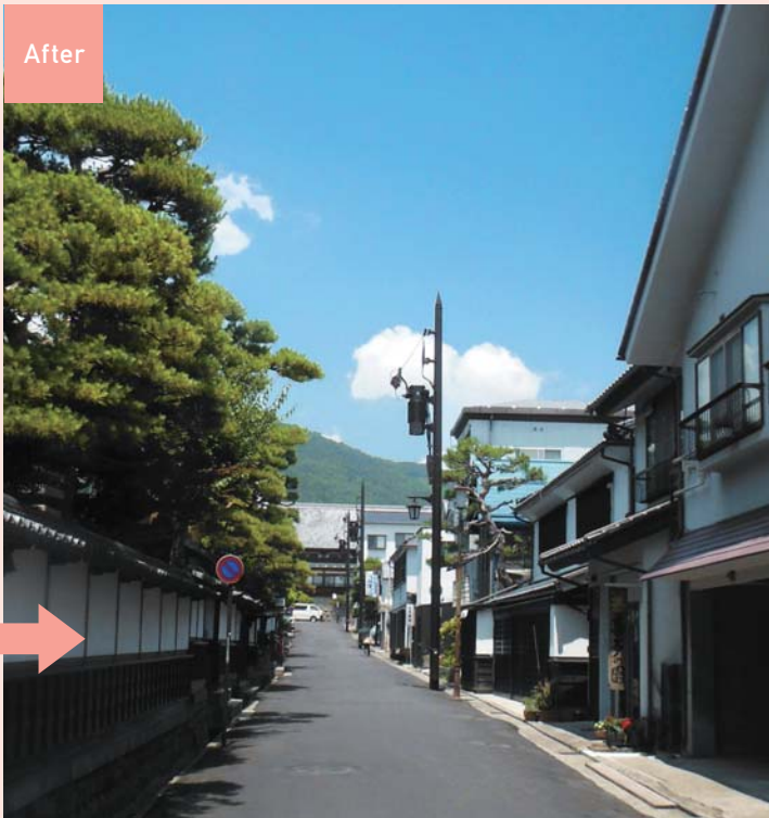
配電線の地中化工事後
