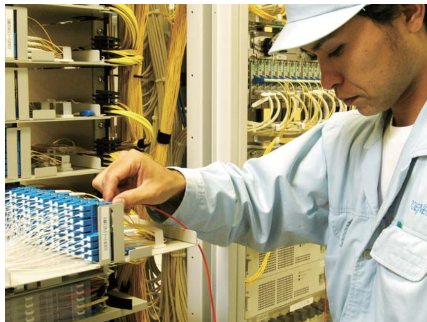
回線接続確認作業
