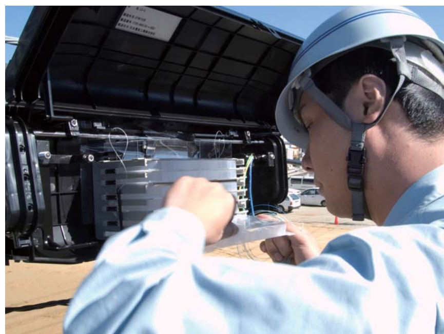
FTTH光ケーブル接続作業
