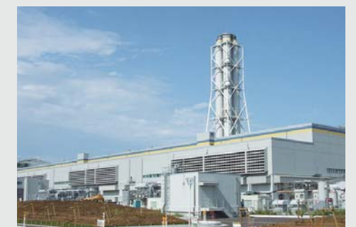
外観(新潟県上越市)
