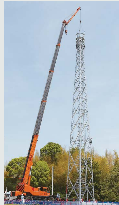
移動体通信基地局の建設
