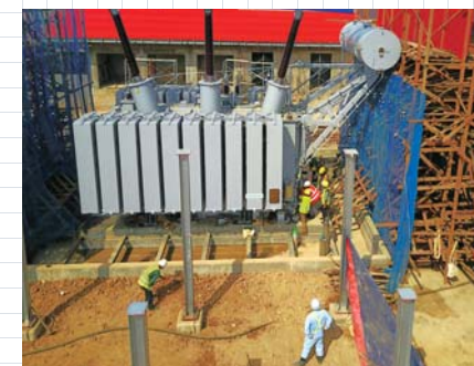
ミャンマーでの変電所建設工事
