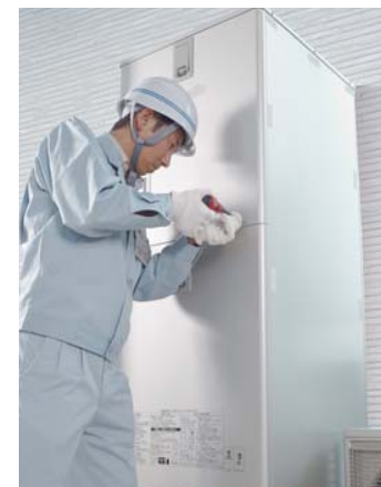
エコキュート設置工事
