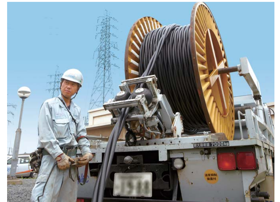
地中線ケーブル布設車「ドラムボーイ」の操作
