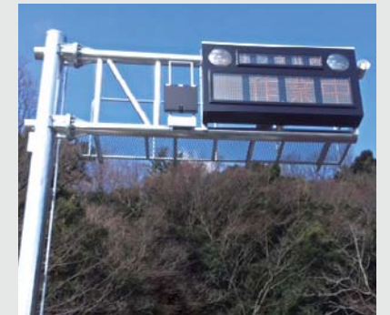
非常用設備更新工事
