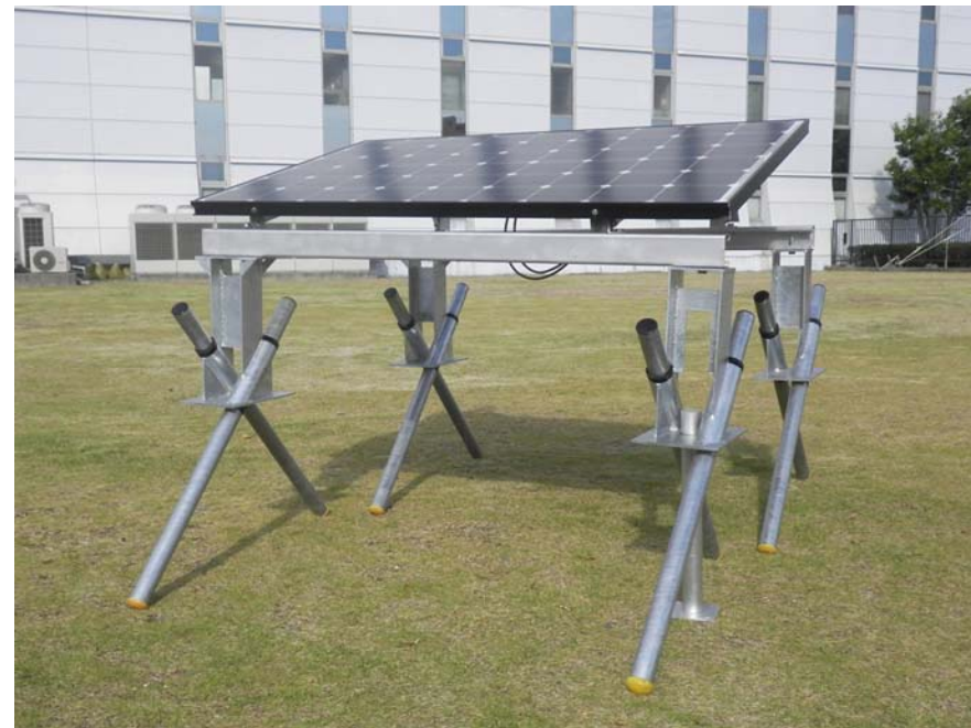
FX鋼管基礎 パネル設置外観
