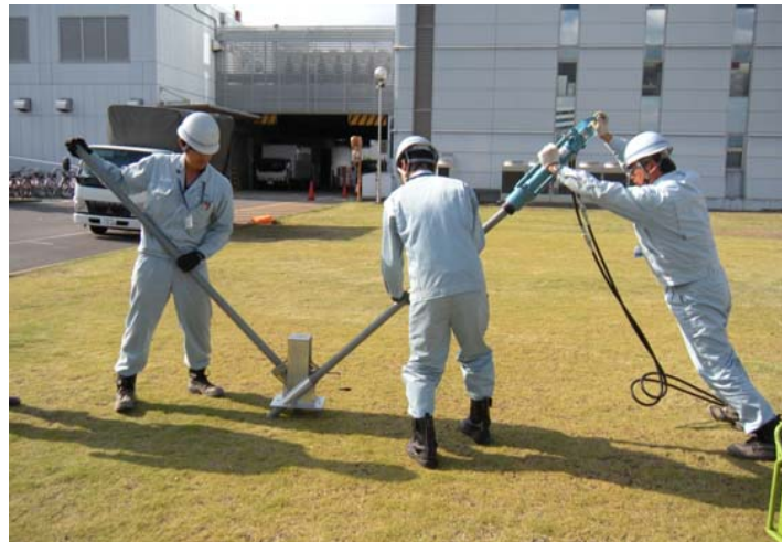
支持鋼管打ち込み状況(油圧杭打ち機使用)
