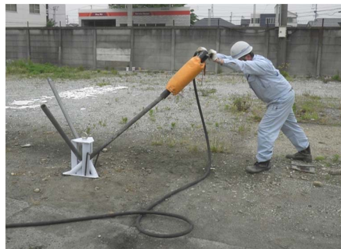
支持鋼管打ち込み状況(コンプレッサー使用)
