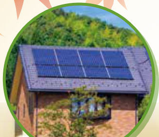
太陽光発電／蓄電池
